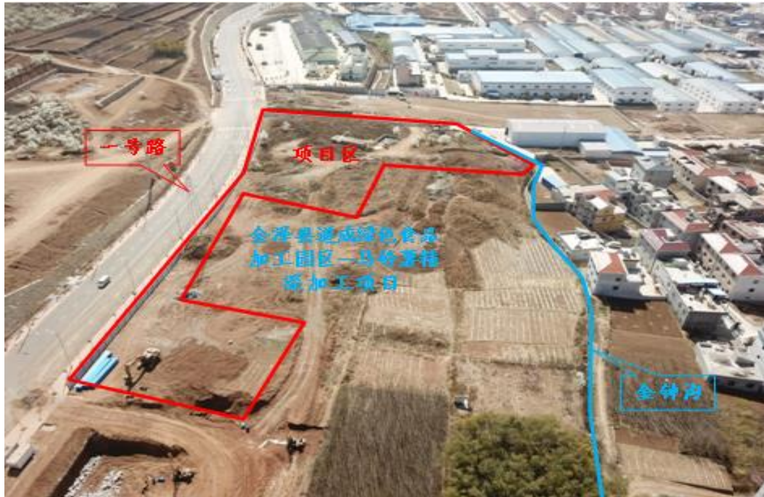
项目区建设现状（2021年4月底）
